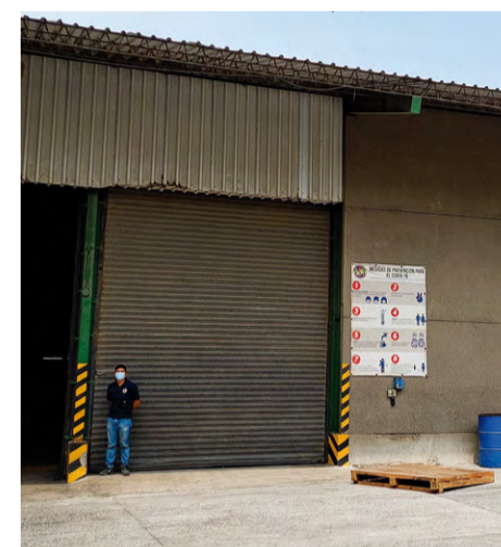
Die neue Trocknungsanlage der Kooperative ist ein wichtiger Faktor, um die hohe Qualität des Kaffees von CIASFA zu gewährleisten.
